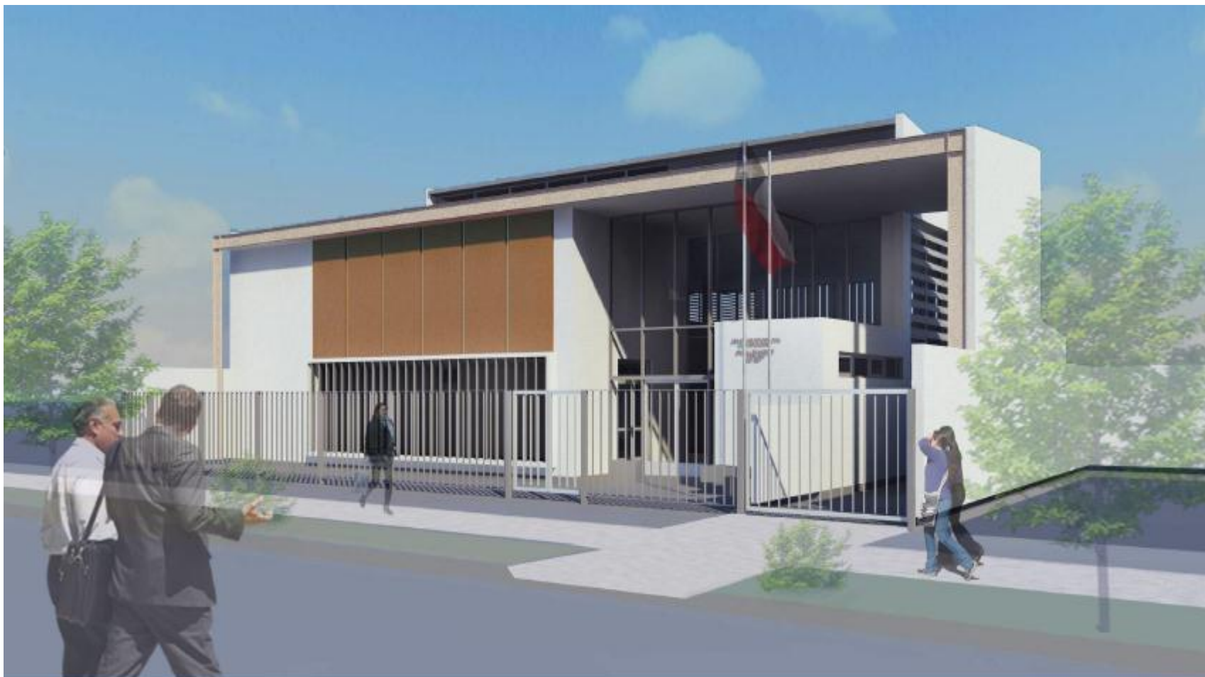
Acceso Principal, calle Ramón Freire nº 351
